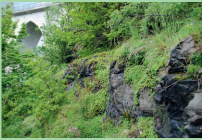
Talhang Eisenbahnbrücke Unterkotzau
